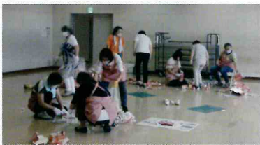
愛用したアンパンマンハウス解体
